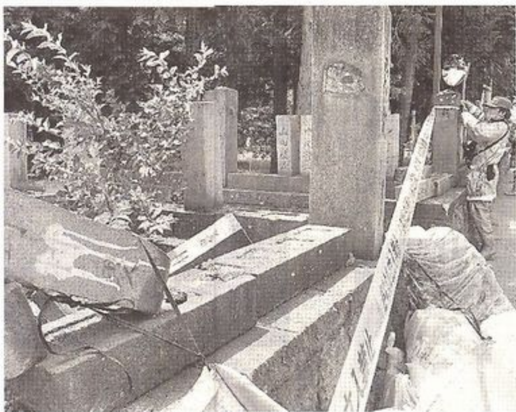
多賀神社では、約1メートルの石柱がいくつも倒れた＝松本市出川町
