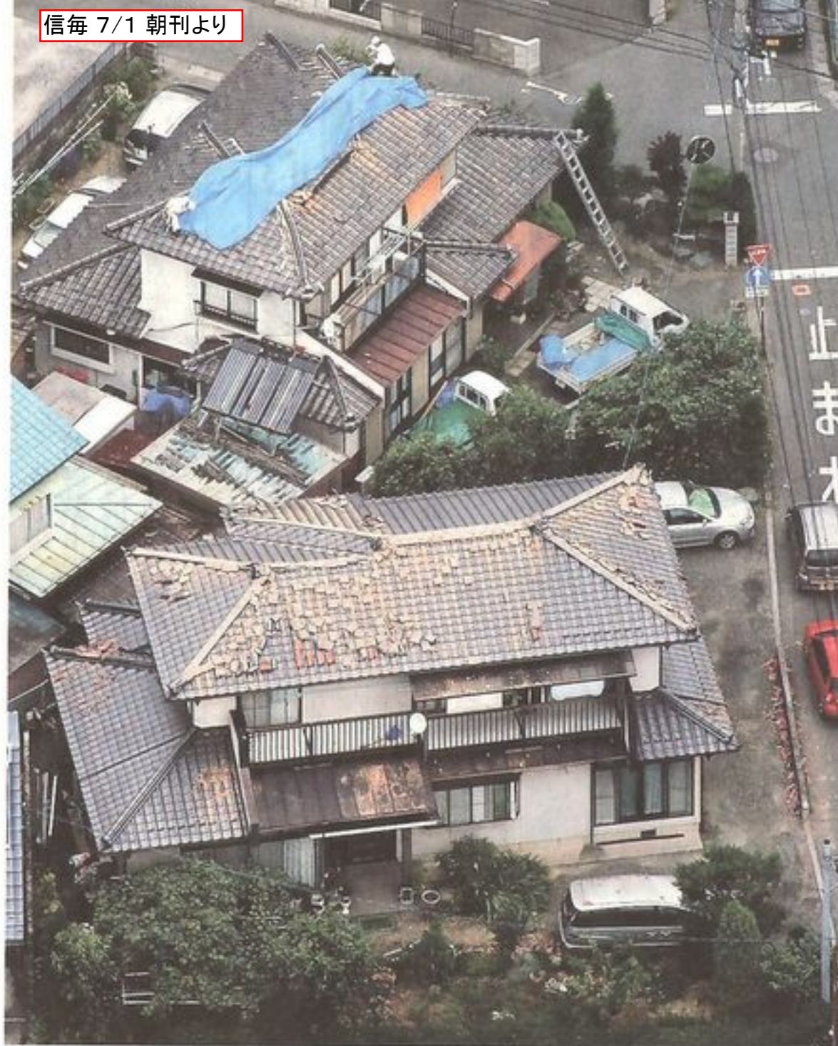
松本市で震度5強を観測した地震で、屋根の瓦が崩れた住宅＝30日午前11時55分、松本市の二子橋近く
